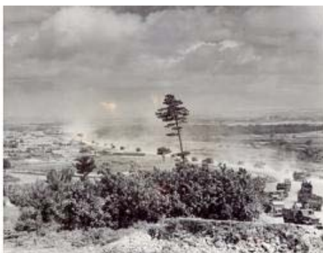
資料名 沖縄戦米軍記録写真0117 規格 20×25cm 解説 6月11日、工兵隊が砕石を道路に敷きつめ、車輛が通れるようにしたが、砂けむりで視界不良となった。
