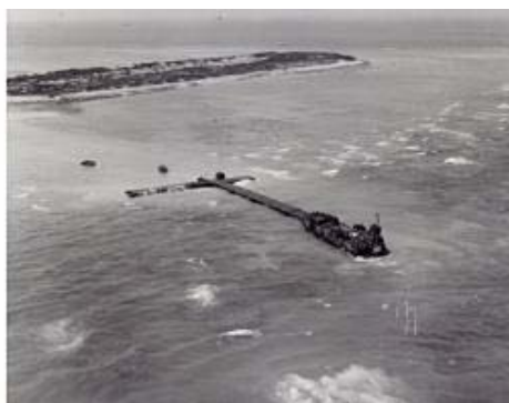
資料名 沖縄戦米軍記録写真0088 規格 20×25cm 解説 4月9日、本島から約6キロ離れた小さな島。LST(平底上陸用舟艇)で荷揚げ作業する米420野戦砲
