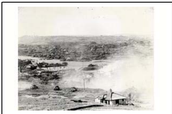
資料名 沖縄戦米軍記録写真0056 規格 20×25cm 解説 5月10日、那覇に通ずる橋はすべて退却した日本軍によって爆破された。
