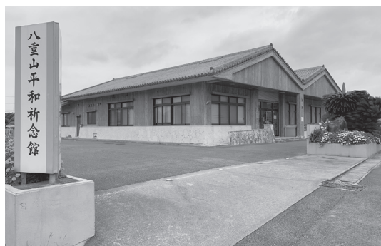
八重山平和祈念館外観
